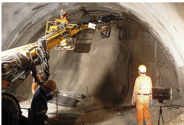
Σχήμα 2-18. Σανίδες προπορείας. © DYWIDAG-Systems International (DSI).
