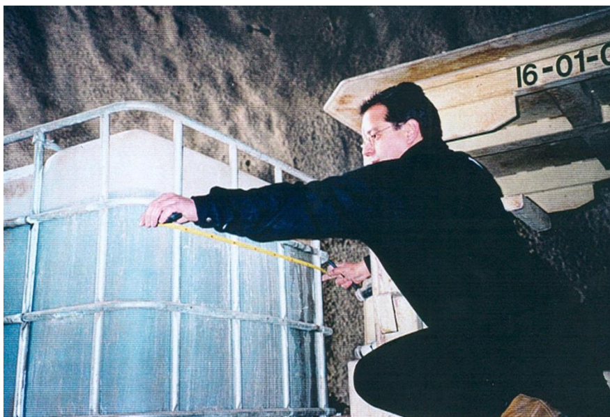
(α) Μέτρηση διαστάσεων δοχείου επιταχυντή (β) Ένδειξη δοσομετρητή Σχήμα 3-10. Επιταχυντικό πρόσμικτο (Μιχαηλίδης & Γαρατζιώτης, 2009)
