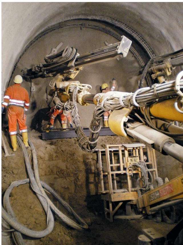
(α) Εγκατάσταση IBO. © DYWIDAG-Systems International (DSI).
