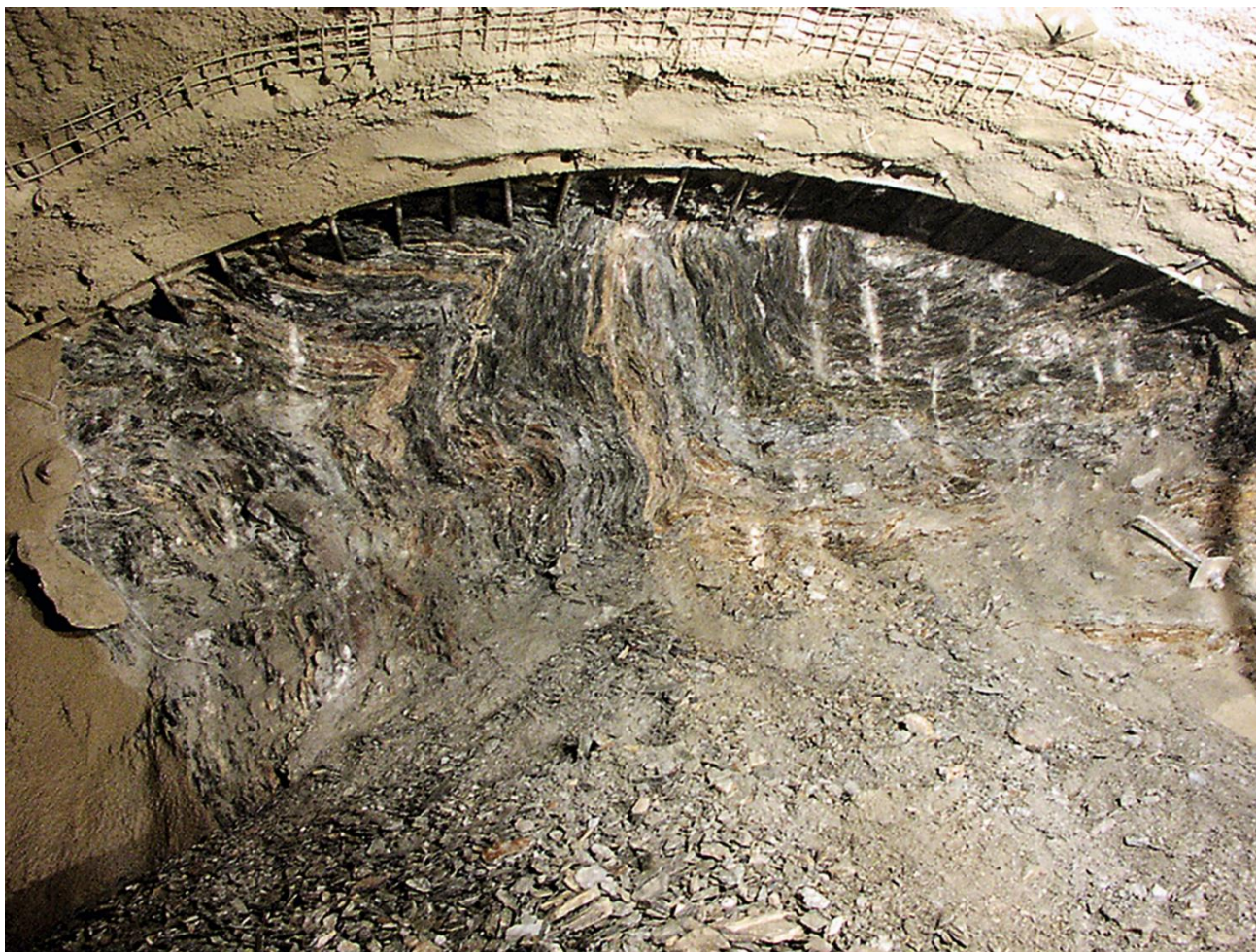
Σχήμα 2-14. Ράβδοι προπορείας τοποθετημένες στην περιφέρεια σήραγγας. © DYWIDAG-Systems International (DSI).
