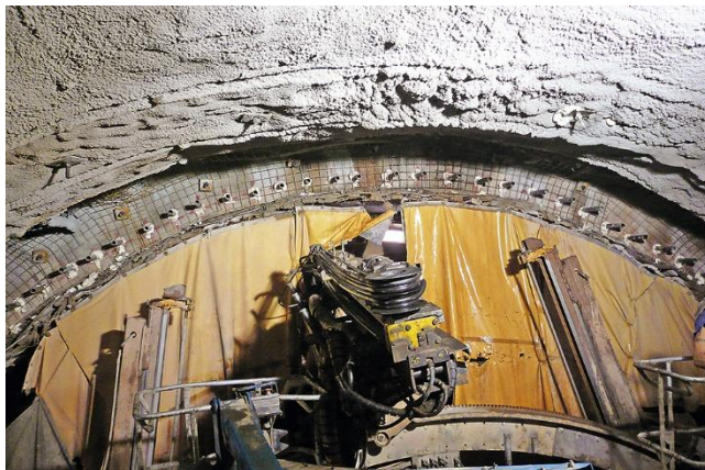
(α) Τοποθετημένες σωληνωτές δοκίδες προπορείας πέριξ της διατομής. © DYWIDAG-Systems International (DSI).
