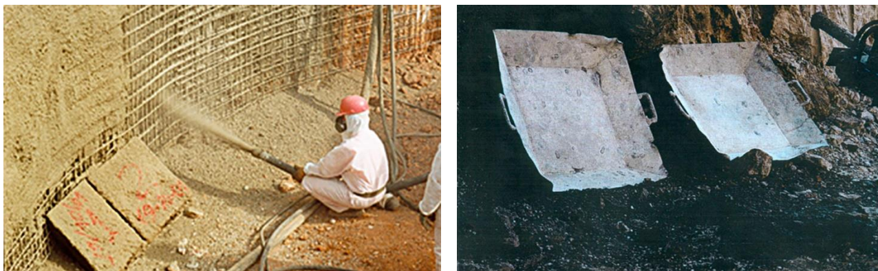
Σχήμα 3-11. Το εκτοξευμένο σκυρόδεμα ελέγχεται με τη λήψη τετάρων πάχους 15cm, ακμής εσωτερικής 60cm και εξωτερικής 80cm, τα οποία πρέπει να γεμίζουν με μία στρώση (Μιχαηλίδης & Γαρατζιώτης, 2009)
