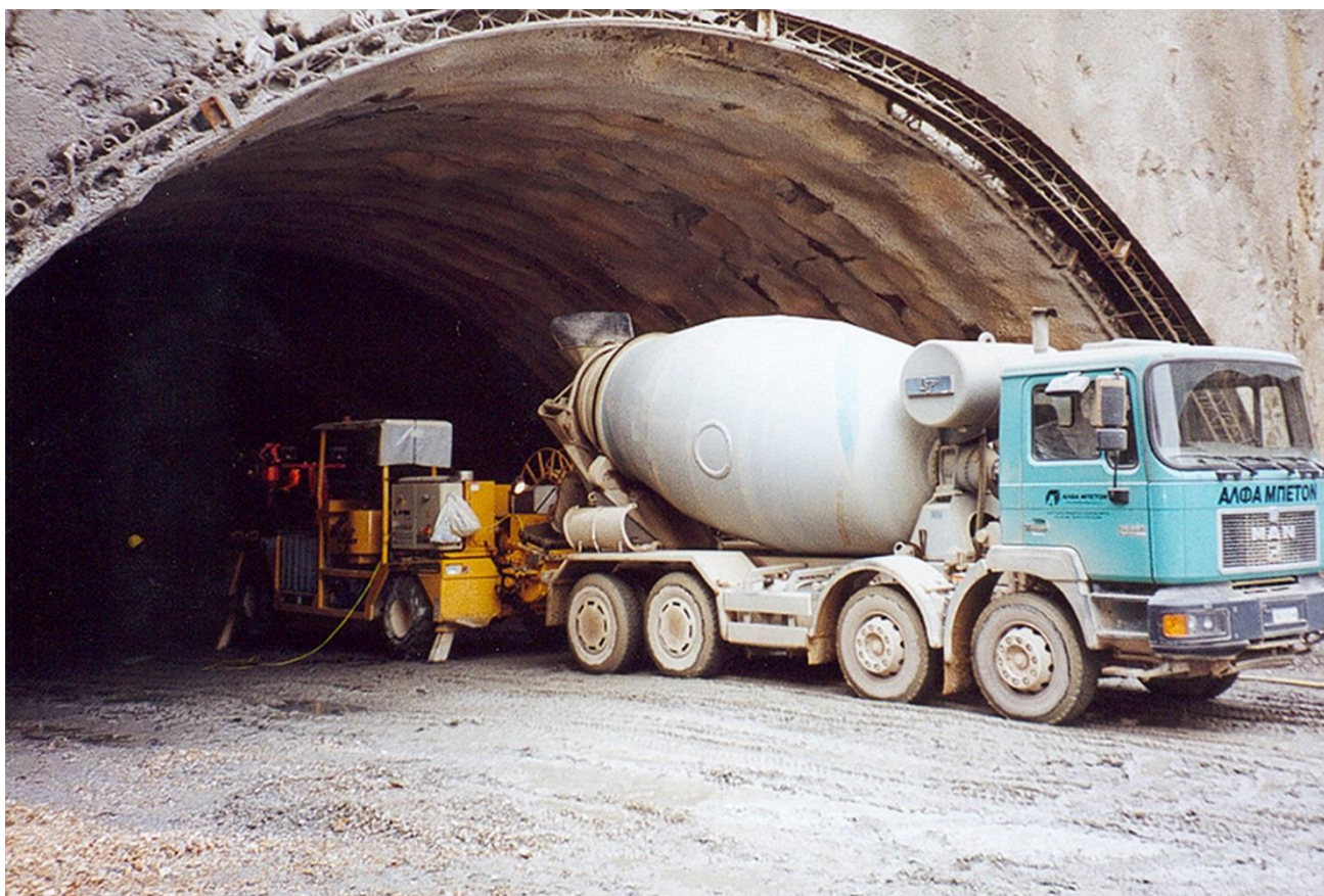
Σχήμα 3-5. Τροφοδότηση χοάνης της αντλίας (Μιχαηλίδης & Γαρατζιώτης, 2009).
