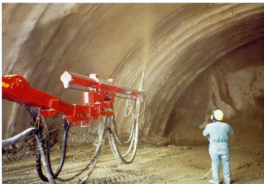
(β) Εκτόξευση με χρήση Robot
